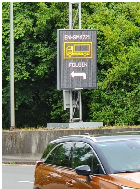
Anzeige des Kennzeichens sowie Aufforderung zum Befahren der Umleitungsstrecke auf der LED-Anzeigetafel
